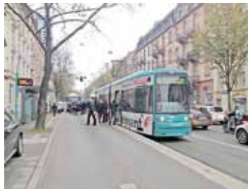
Das wird zu eng! „Beispiel für eine Haltestelle mit Fahrbahnkap“ (Forschungsgesellschaft für Straßen- und Verkehrswesen FGSV)
