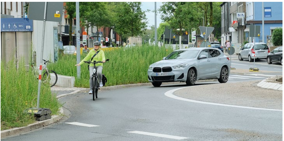
Neuer Kreisverkehr Weitmar – Mark
