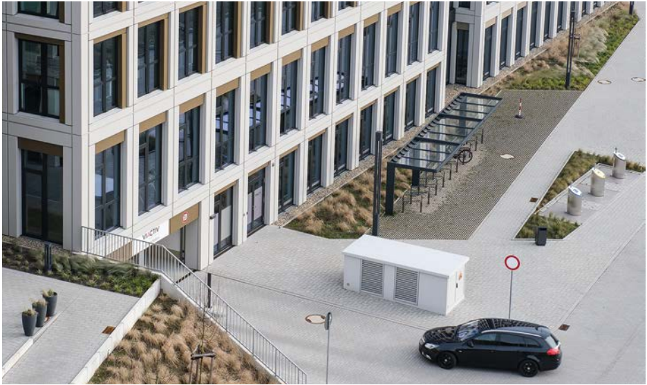
Zufahrt Fahrradgarage, Fahrradabstellanlage Via-Activ
