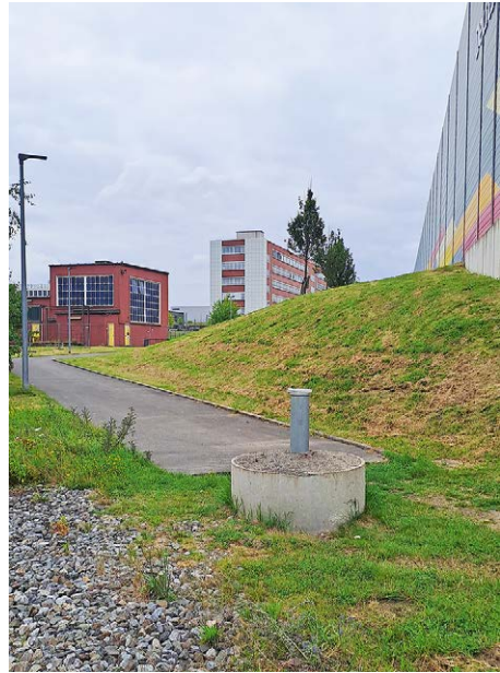
Östliche Zufahrt vor dem DHL Gebäude auf Mark 51.7
