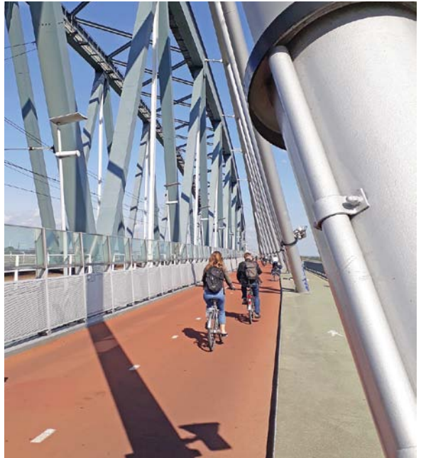
Waalbrücke bei Nijmegen
